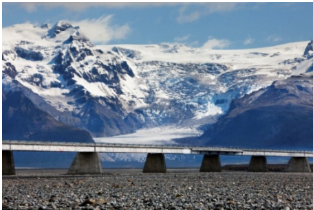
Skeiðarárbrúin yfir þurruvegum árið 2010.
